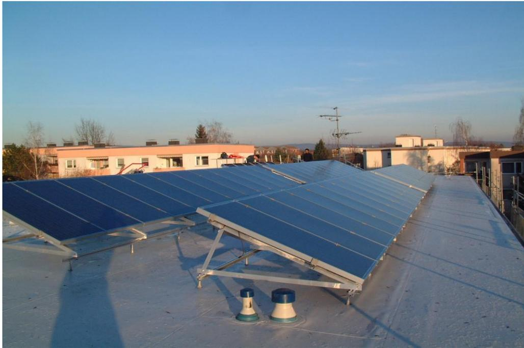
**Flachdach „Dach-parallel“** / Richtwert: 15 m<sup>2</sup> / kWp
