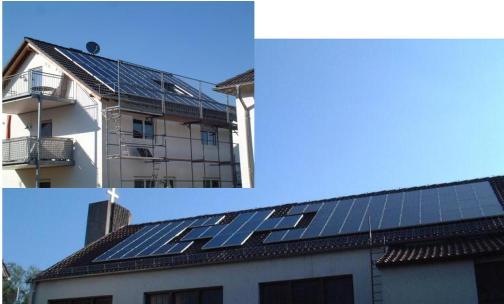
**Indachanlagen u. Solar-Roof** / Richtwert: 10 m<sup>2</sup> / 1 kWp
