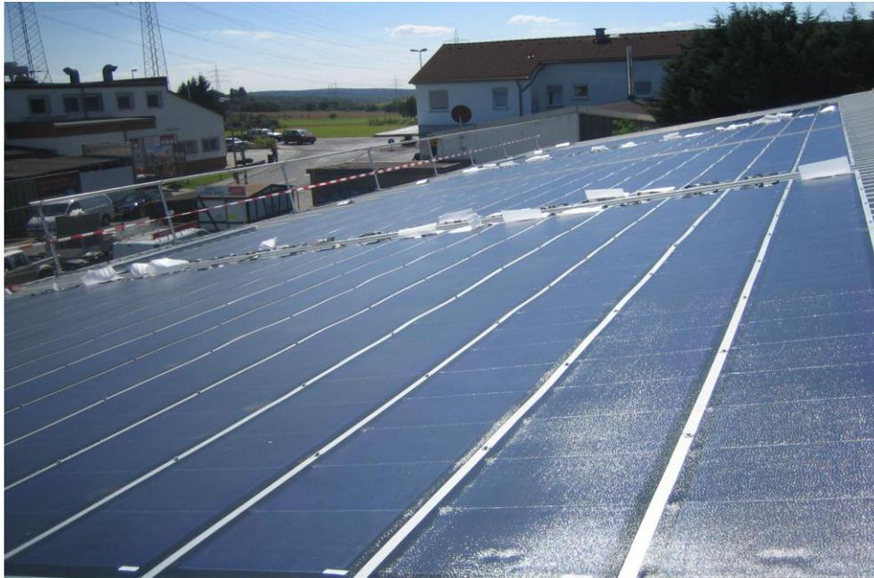
**Fassade / parallel** / Richtwert 1 kWp = 10 m<sup>2</sup>
