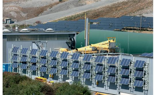
Freiflächen, Dächer und Gebäudefassaden werden gezielt genutzt, um mittels Photovoltaikanlagen Strom zu erzeugen.
